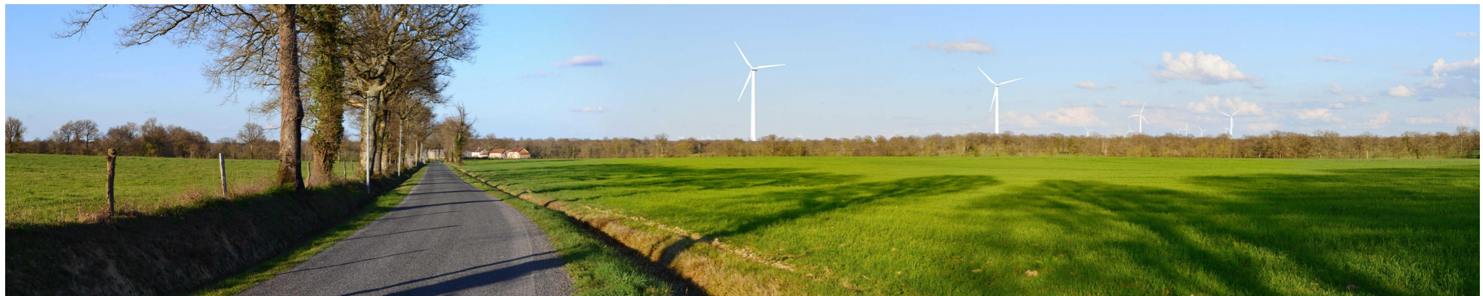
Simulation paysagère depuis la route départementale RD63. L'espace de respiration entre les éoliennes du projet éolien de Croix du Picq est ici souligné.
